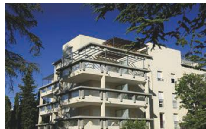
Le Domaine des Grands Cèdres - Marseille 10 e Architecte : Vincent Inglezakis
